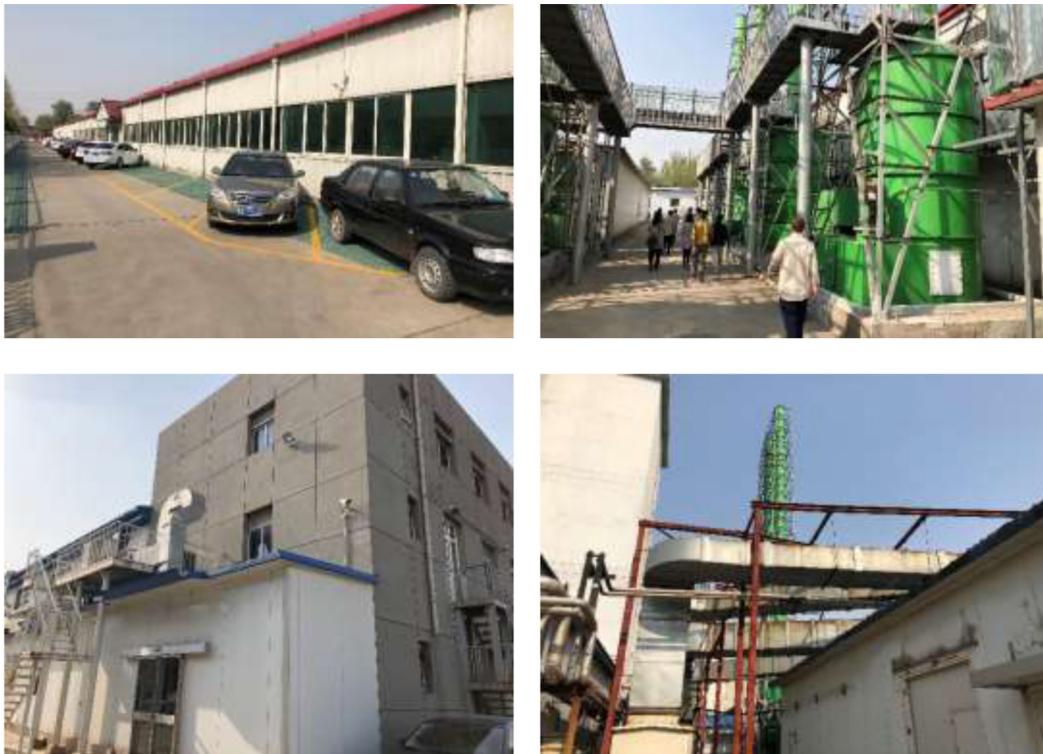
图 2-3 公司厂区现状图
